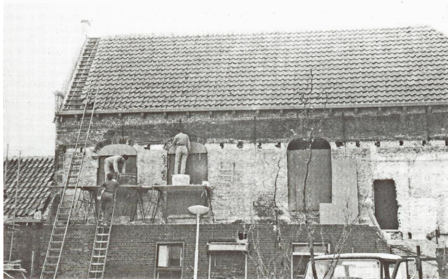
26. De westelijke gevels tijdens de restauratie.
